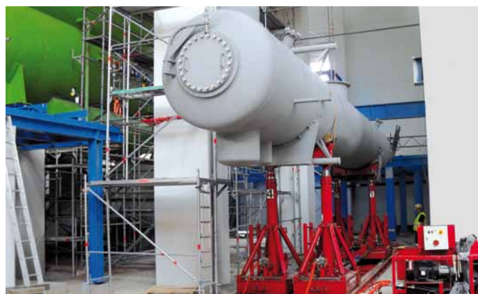
Einbringen eines Behälters aufs Fundament im Heizkraftwerk der Stadtwerke Bonn
